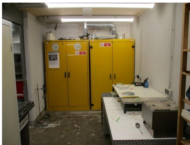
PGS kasten voor opslag van (brandbare) vloeistoffen
